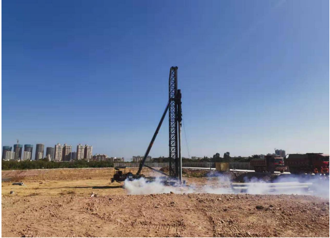
江誉诚小学项目桩基启动
